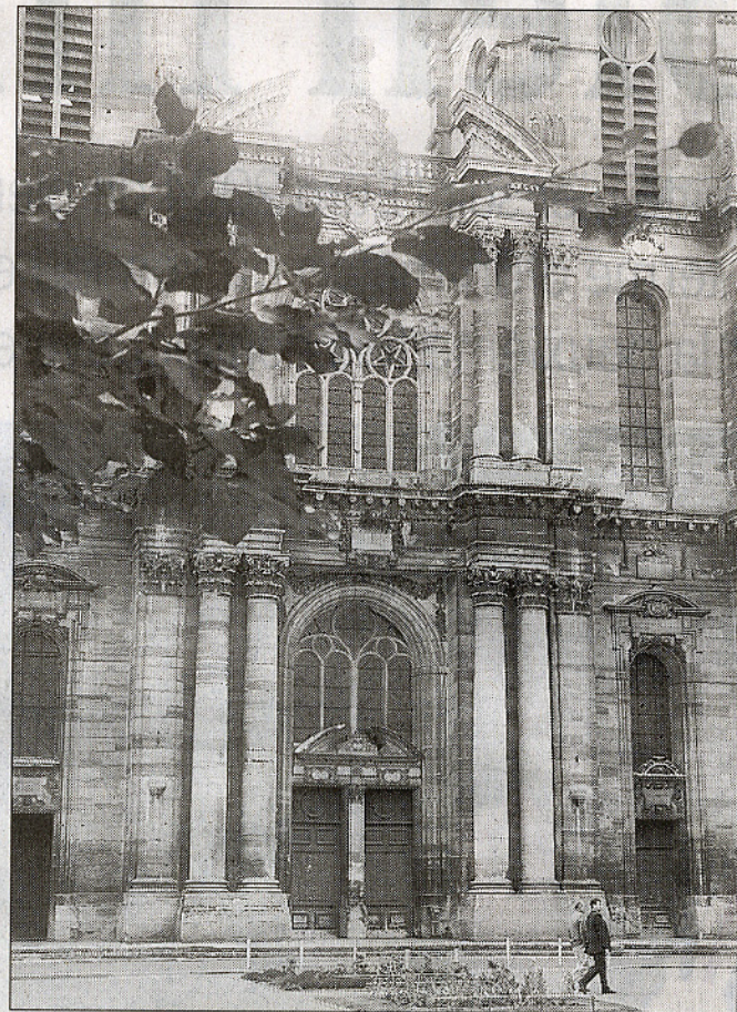
Des tunnels de protection seront mis en place sur les deux entrées principales de la collégiale. Ces deux portes resteront accessibles au public.
