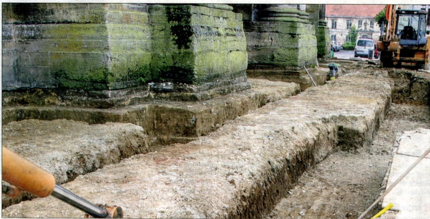
L'entreprise doit remettre à niveau les fondations avant de poser la couche de béton.
