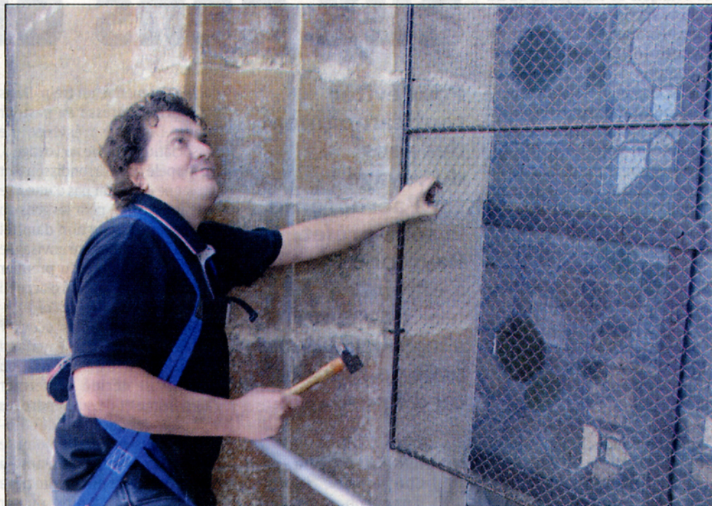
Charles-Henri Billerey, maître-verrier, a fixé les grilles de protection en inox sur le joint des pierres.
